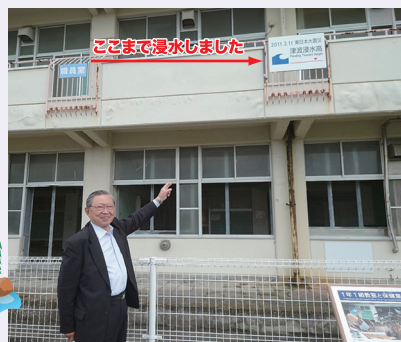
仙台市立荒浜小学校の津波浸水高
